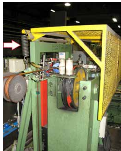
Kuva 15. Suuren suojuksen käsittelyä helpotetaan vankalla jousella (osoitettu nuolella). Muuten suojaus on huono, koska se on päädyistä auki.
