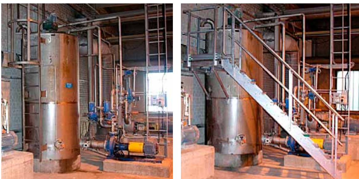
Kuva 9.b Säiliön päälle aikaisemmin meneet tikkaat (vasen kuva) on korvattu portailta (oikea kuva).
